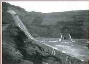
竣工当初の土堰堤（大正 4 年）
