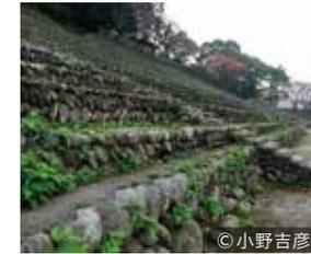
コンクリートを使わず石だけで、長さ170m、27段を積み上げています。
