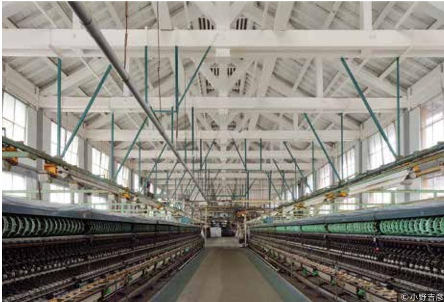
旧富岡製糸場 繰糸所内部〔富岡市〕 繭から糸を取る作業が行われていた建物。長さ約140mの、世界最大規模の器械製糸工場だった。建築に「トラス構造」を用いることで、建物の中央に柱のない大空間を作り出しています。
